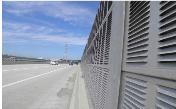
방호벽, 방음벽 전경
