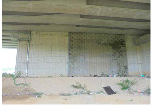
A1 접속옹벽 상태양호
