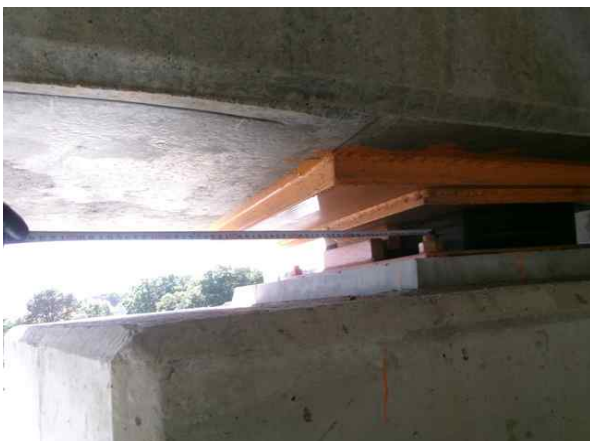
받침장치 연단거리 측정
