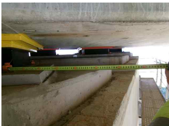
받침장치 연단거리 측정
