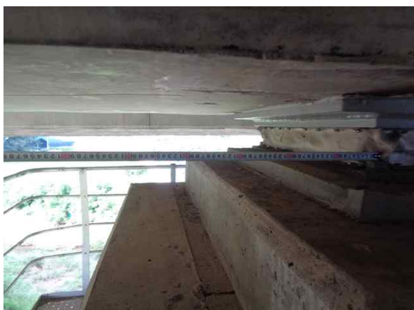
받침장치 연단거리 측정
