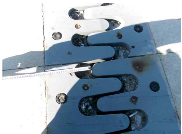
신축이음 이동량 측정
