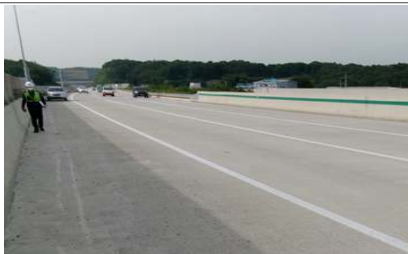
작업사진(도보 이동점검) 전경
