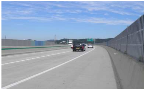
방호벽, 방음벽 전경
