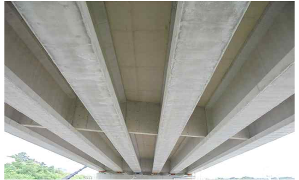
거더, 바닥판하면 전경
