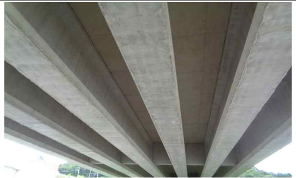
거더, 바닥판하면 전경
