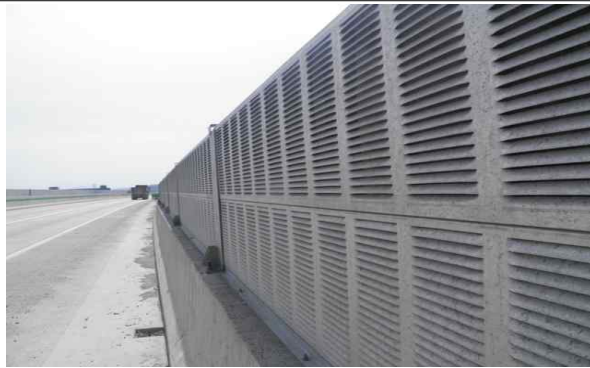
방호벽, 방음벽 전경
