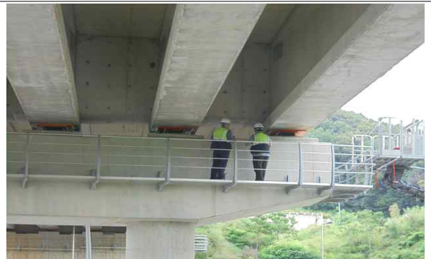
작업사진(도보 이동점검) 전경
