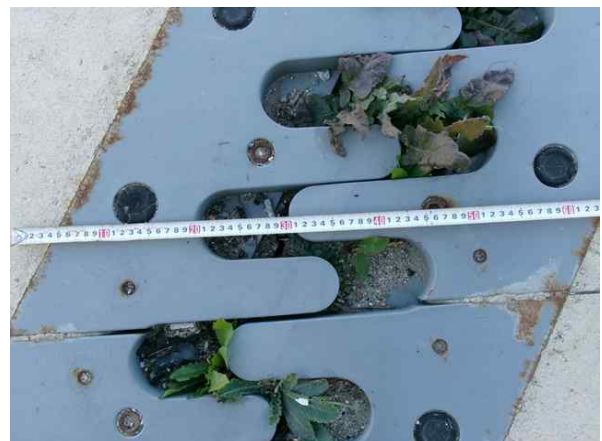
신축이음 이동량 측정
