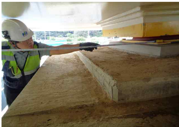
받침장치 연단거리 측정
