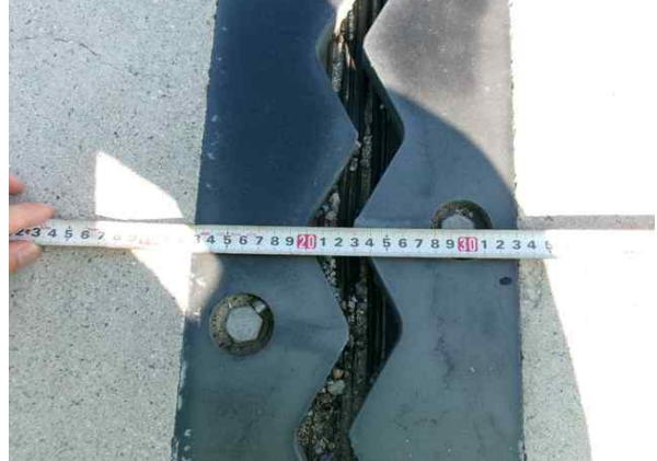
신축이음 이동량 측정
