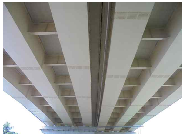
거더(S.T.B), 바닥판하면 전경
