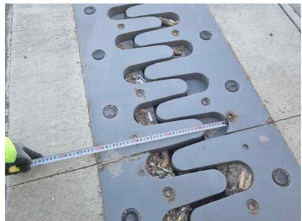
신축이음 이동량 측정
