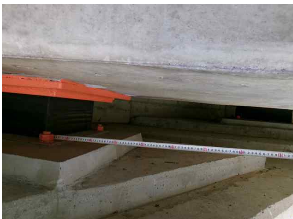
받침장치 연단거리 측정
