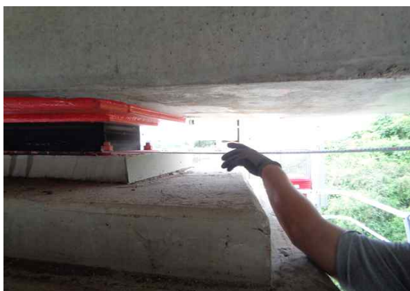
받침장치 연단거리 측정
