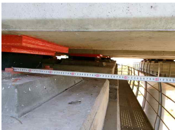
받침장치 연단거리 측정
