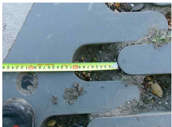
신축이음 이동량 측정
